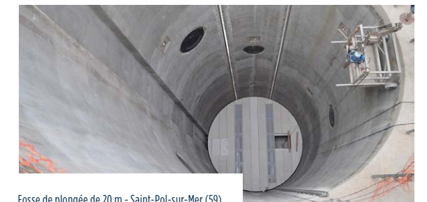
Fosse de plongée de 20 m - Saint-Pol-sur-Mer (59)
