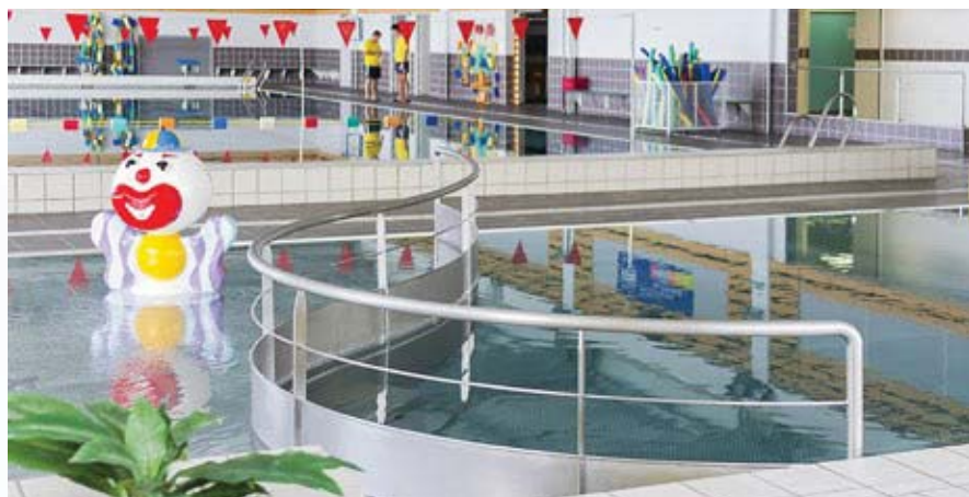
Piscine de Cosne d'Allier (03) - Maître d'œuvre : CHM Architectes - Photo : Pascal François
