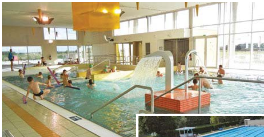
Piscine des Weppes à Herlies (59) - Maître d'œuvre : DUVAL-RAYNAL ARCHITECTURE
